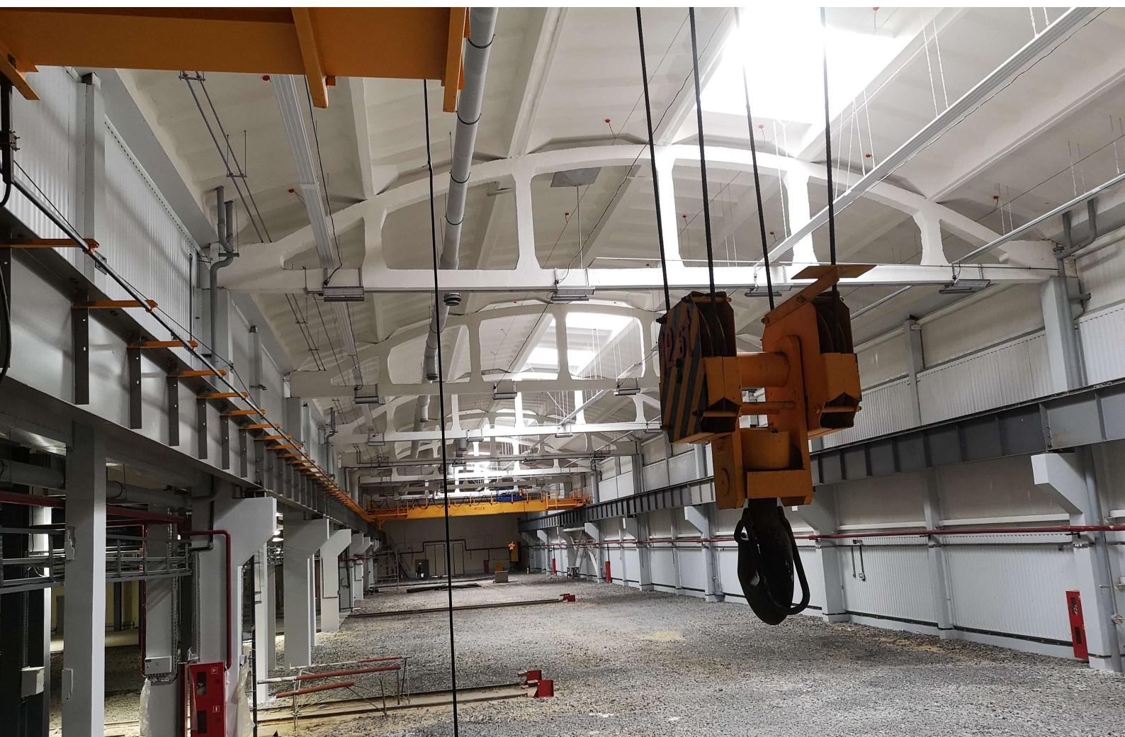
Производственно-складское помещение «БЕЛАРУСЬКАЛИЙ», Гомельская обл., Беларусь, 2018 г.
